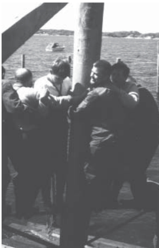
Sättning av stolpar, dock före trimaranens tid
